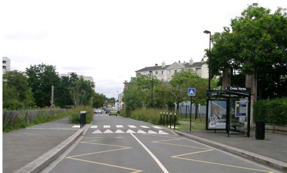
Aménagement d'un plateau traversant rue de la Pilate
