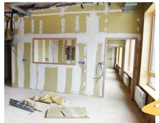
Les salles de classe prennent forme: cloisons montées, en attente de la pose des vitres.
